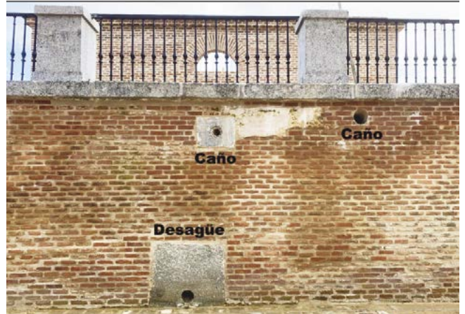
Arriba, muro sur del vaso del estanque donde se aprecian la boca de desagüe y los caños de llenado procedentes de la noria. A la izquierda, imagen actual del conjunto.
